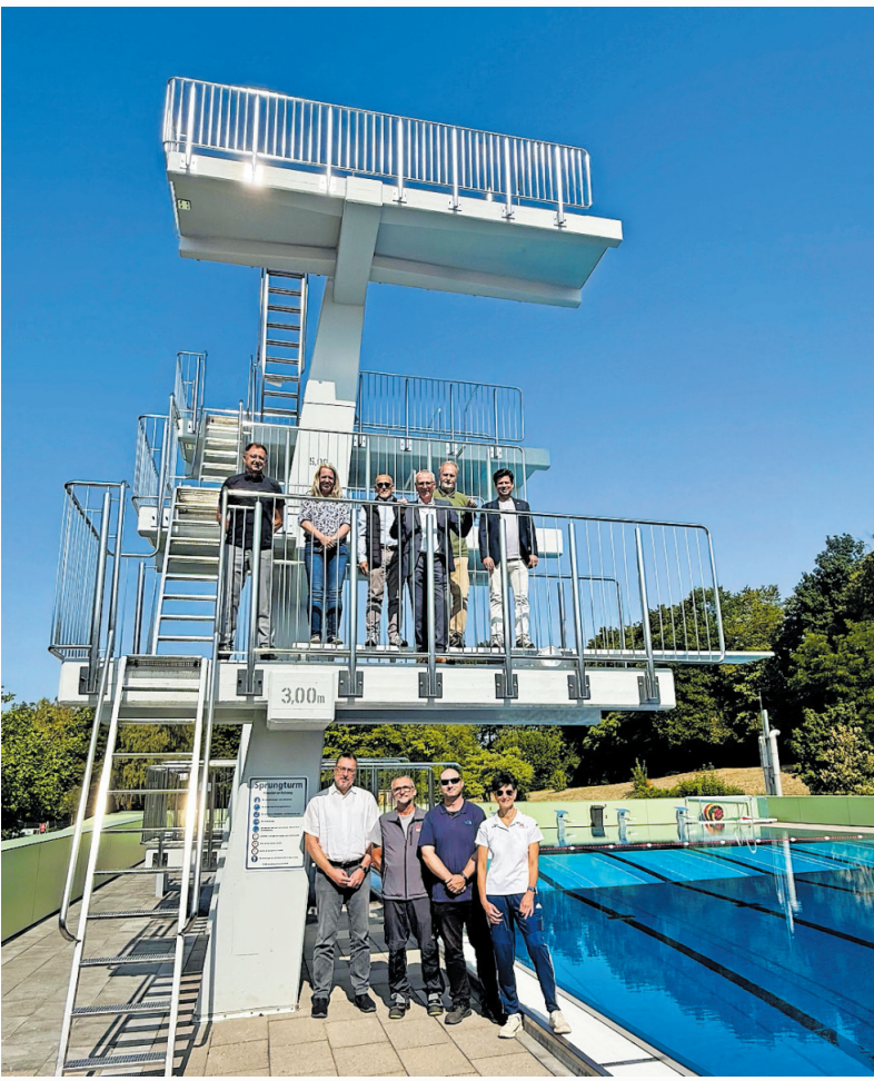
Alle am Sanierungsprojekt Beteiligten mit Manuel Steinbrenner (oben rechts) auf dem neuen Sprungturm am Springerbecken
